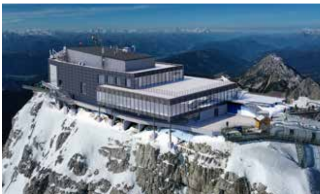
Die rundum erneuerte Dachstein Bergstation
